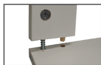
A. Colocación de parante y frente
