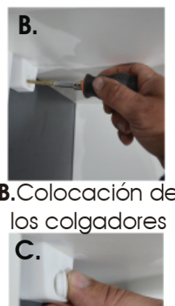
B. Colocación de los colgadores
