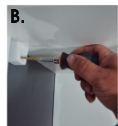
B. Colocación de los colgadores
