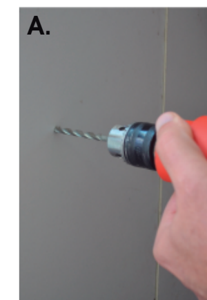
A. Tomar medidas y perforar la pared
