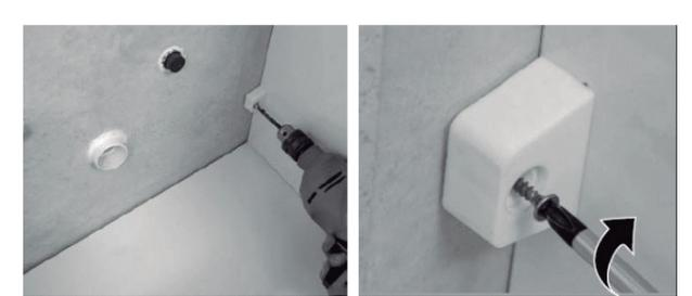
Centre el Mueble tomando como referencia el desagüe. Haga las Perforaciones con Mecha de 8mm, coloque Tarugos Fisher. Presente el Mueble y fijelo con Tornillos Parker, utilice las arandelas plásticas. Por último, coloque las tapitas.
